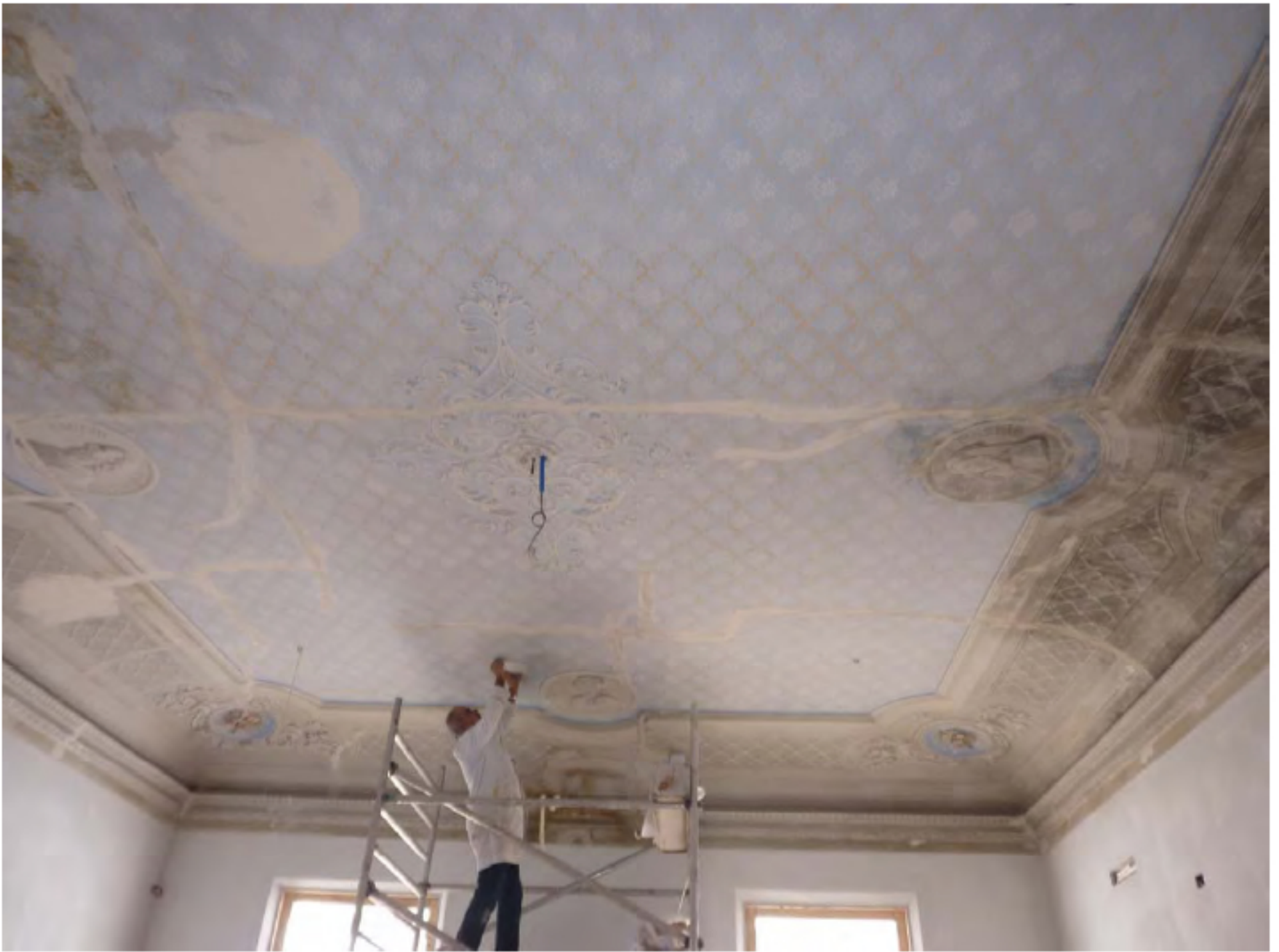
Sala dei Giuristi. Fase di pulitura e consolidamento dei dipinti
