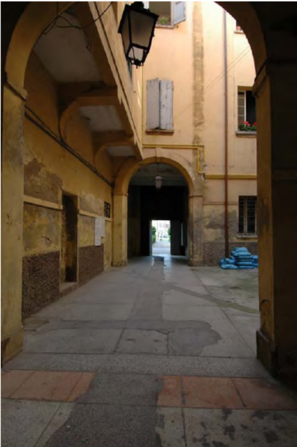
Androne verso viale Vittorio Veneto prima del restauro
