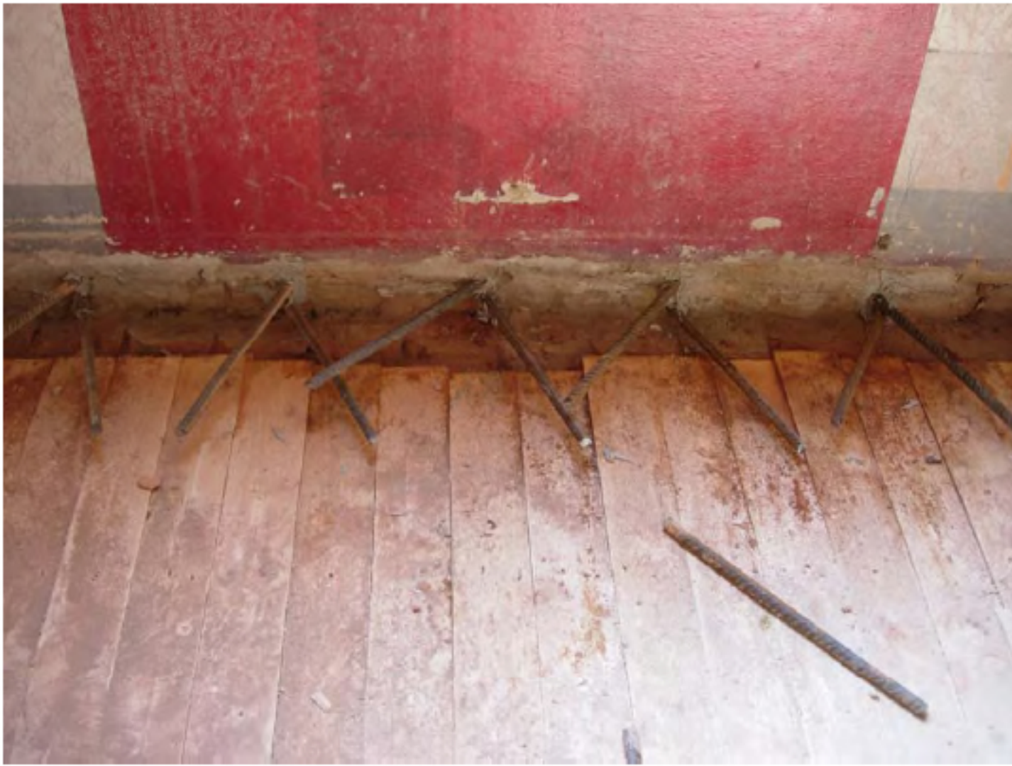
Inserimento di barre d'acciaio o chiodature sui bordi perimetrali
