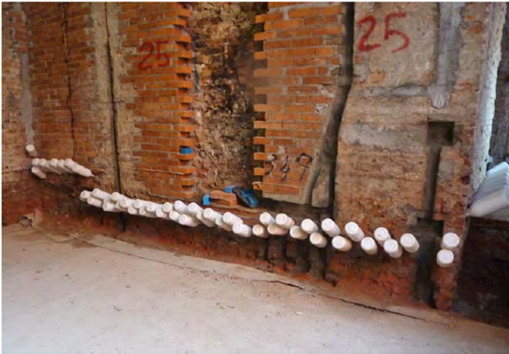
Risanamento delle murature mediante sbarramento chimico
