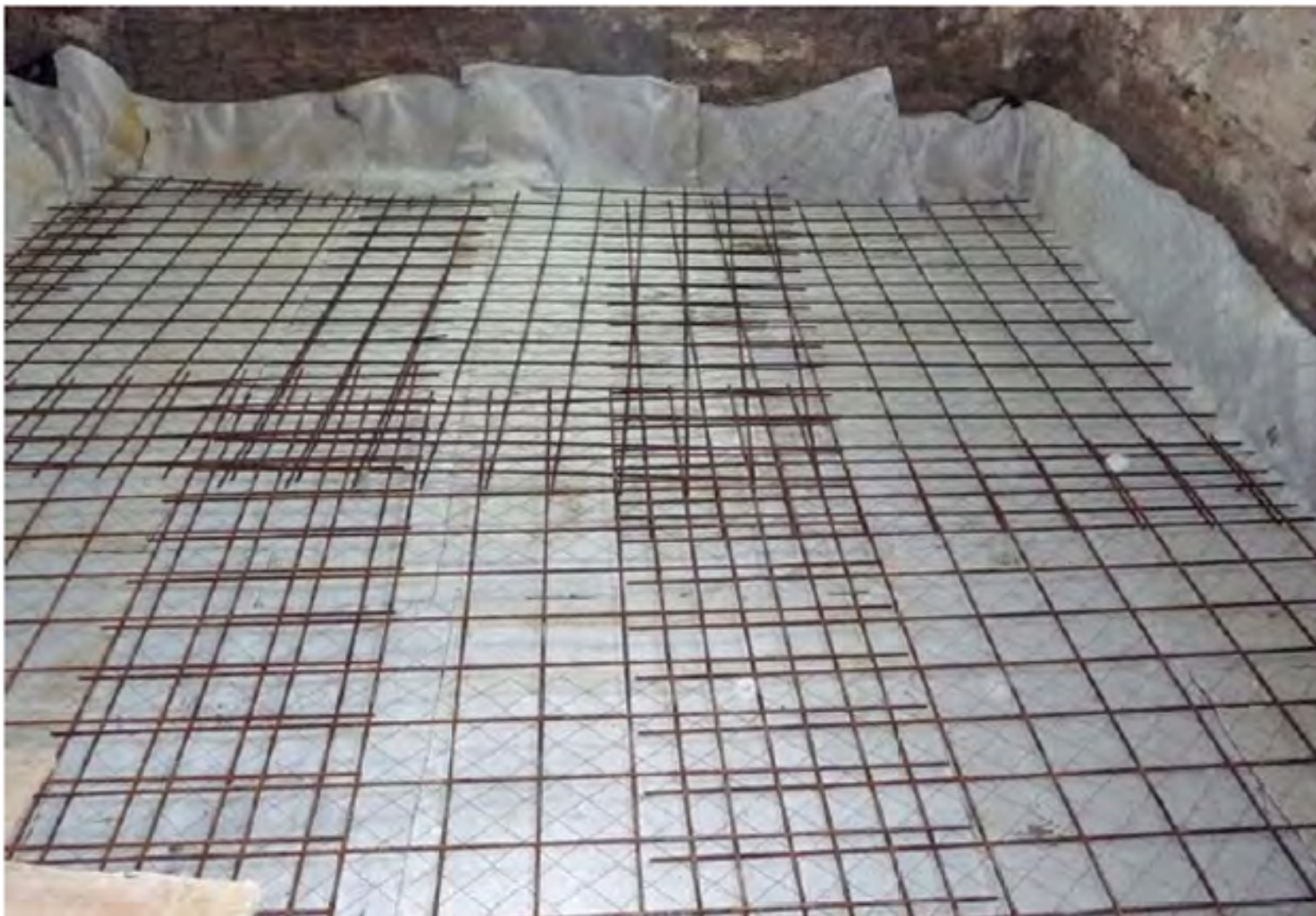
Impermeabilizzazione del piano terra mediante telo bentonitico
