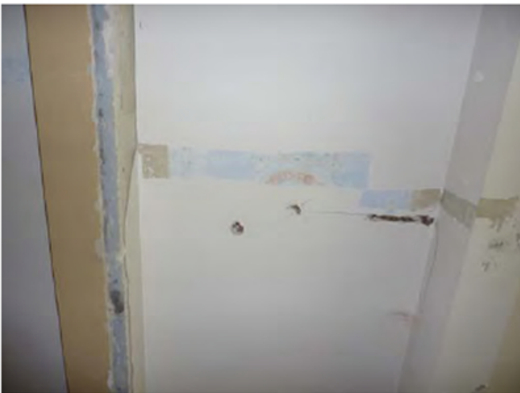
Sala futura Segreteria al secondo piano prima del restauro. Particolare delle stratigrafie che evidenziano la presenza di un soffitto decorato
