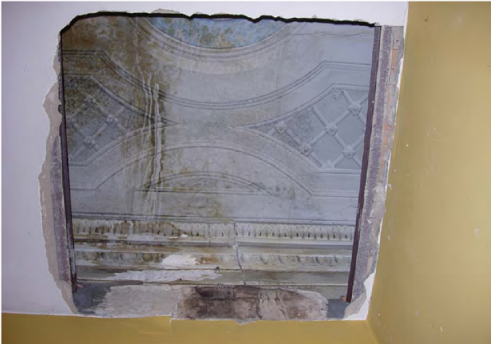
Sala dei Giuristi - Particolare del ritrovamento del soffitto decorato al di sopra della controsoffittatura
