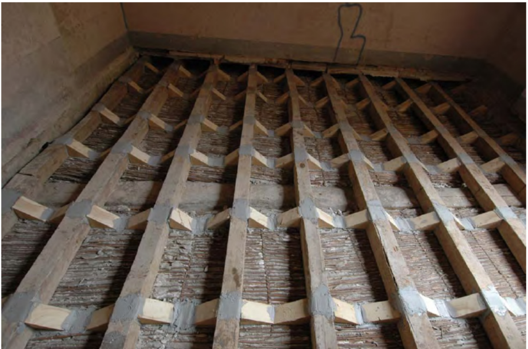
Consolidamento delle aelle poste all'intradosso del primo piano
