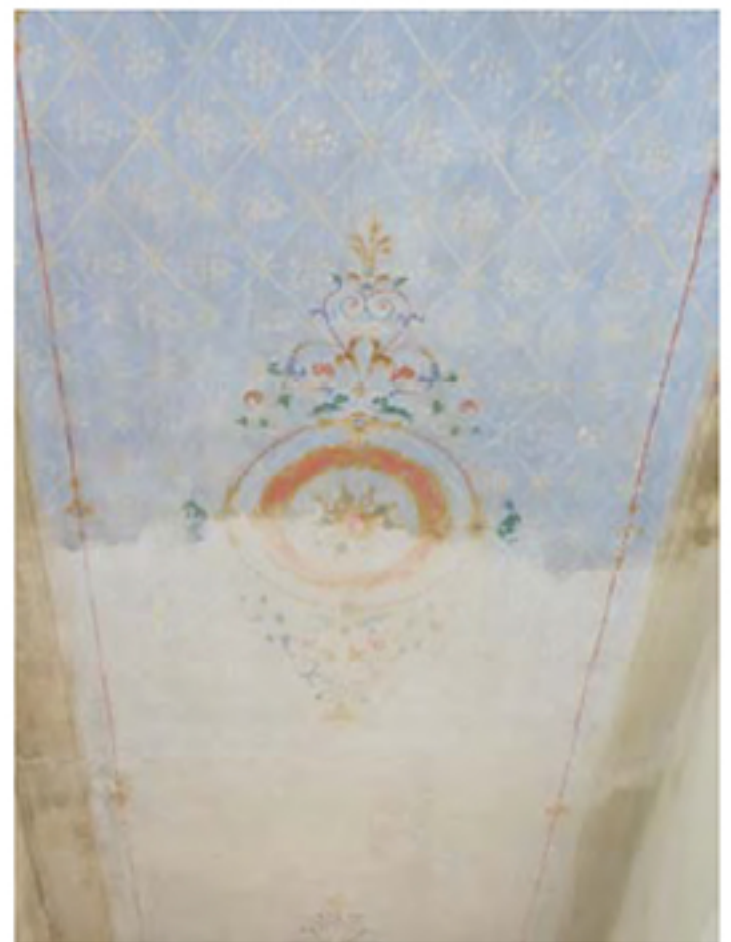
Sala futura Segreteria al secondo piano, particolare della ripulitura del soffitto
